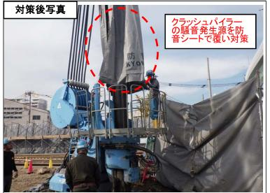
大阪市下水道科学館(旧)駐車場(敷地境界北側近傍)で、鋼矢板圧入作業を行っていた。 管理 地中障害物対応鋼矢板圧入作業を行うためのケーシングオーガーの作業音が、騒音の原因と考えられる。 値超 基本対策として、作業エリア周辺に防音シートを設置し作業を行っていた。
