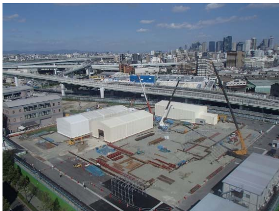
写真1 工事状況写真(2018年10月)
