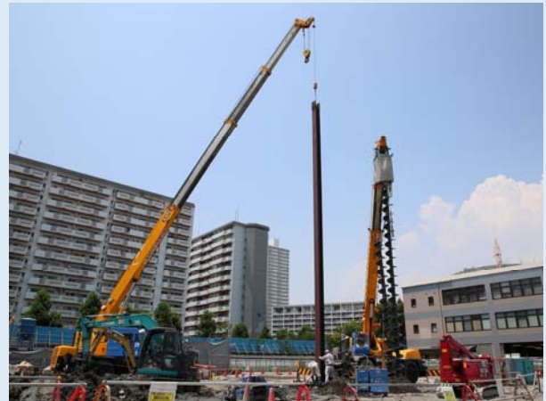
・道路横断部：鋼矢板工・掘削工
