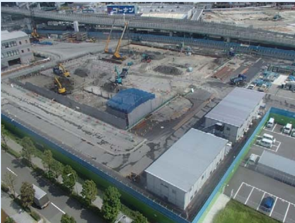
・分配槽立坑：圧入ケーソン工
