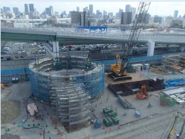
・分配槽立坑：圧入ケーソン工
