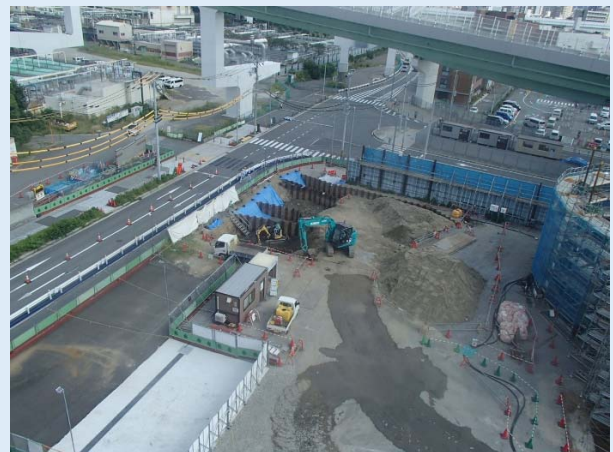
・道路横断部：鋼矢板工・掘削工
