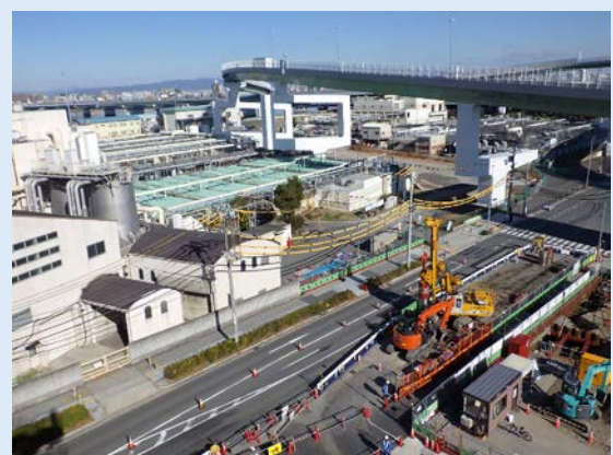
・道路横断部：鋼矢板工・掘削工
