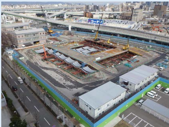
・分配槽立坑：圧入ケーソン工
