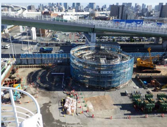
・分配槽立坑：圧入ケーソン工
