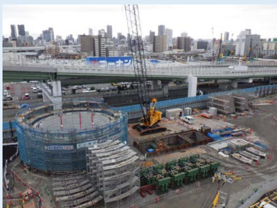
・分配槽立坑：圧入ケーソン工
