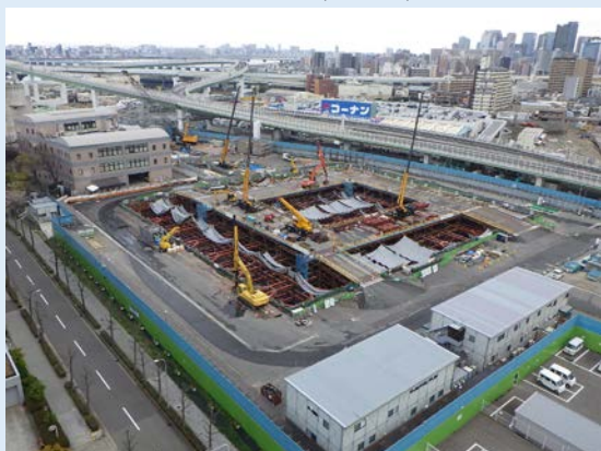
・分配槽立坑：圧入ケーソン工
