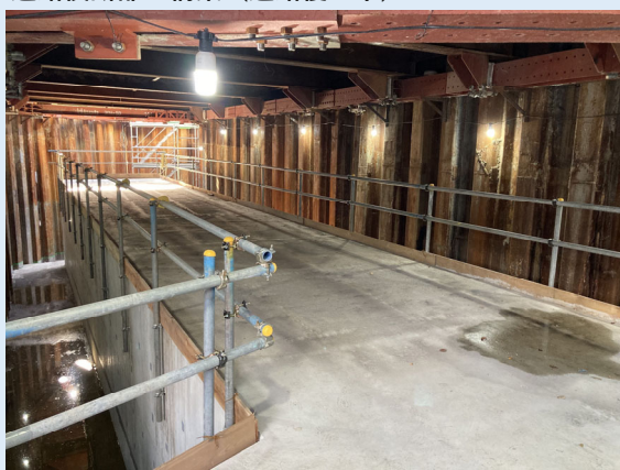
・道路横断面部：構築（道路覆工下）
