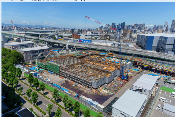
・水処理施設本体内工：躯体工
