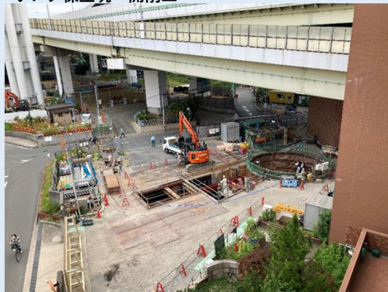
・ポンプ棟立坑：開削工
