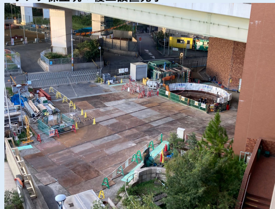
・ポンプ棟立坑：覆工設置完了
