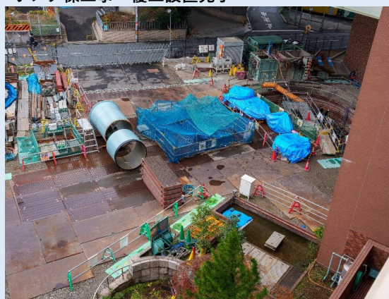
・ポンプ棟工事：覆工設置完了
