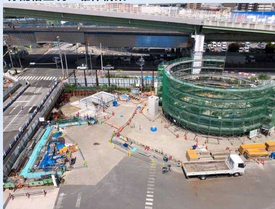
・ポンプ棟工事：躯体構築
