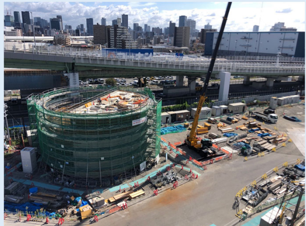
・ポンプ棟工事：躯体構築
